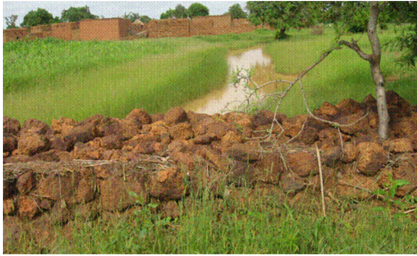
Ouvrage CES/DRS à Ouétigué
