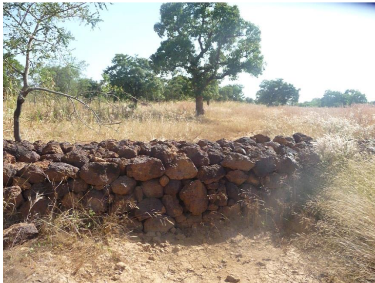
Traitement de ravine à Rondolga
